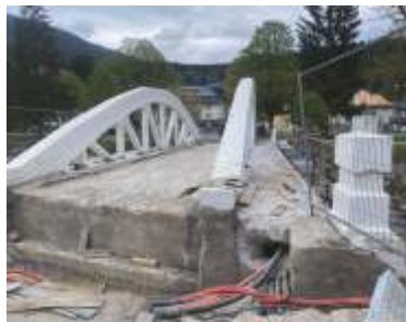
Ilustrační snímek z opravy mostu: -dp-
