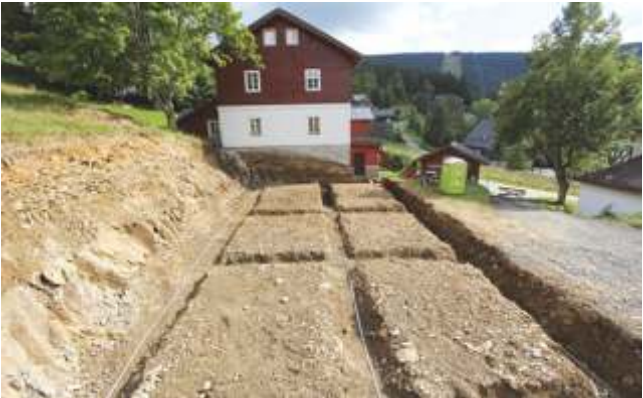
Zemní práce 1. etapy stavebních prací.
