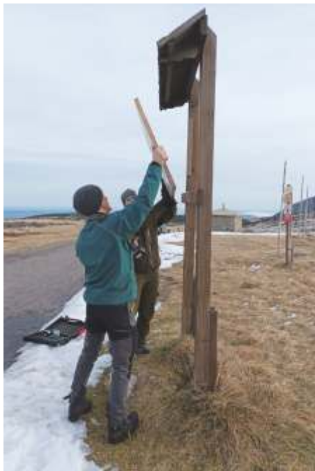
Dřevěný panel před úklidem.
