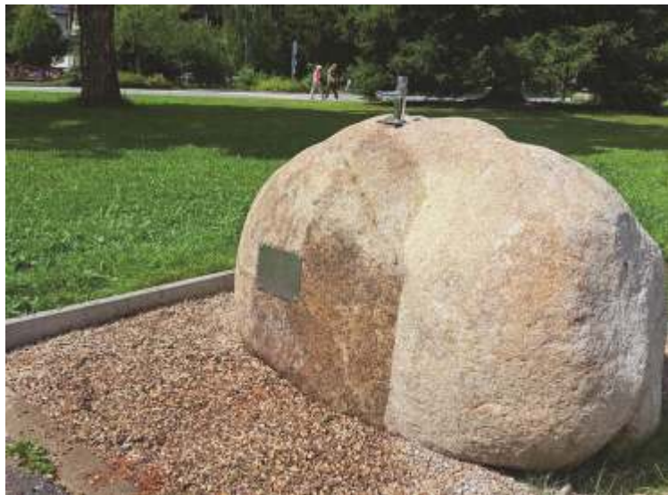
Když zmáčknete na kamenném pitku tlačítko, následně 10 vteřin vytéká voda. Pitko je označeno nerezovou tabulkou, okolí je tvořeno obrušnicí a vyplněno kačirkem, do kterého se vyteká voda vsakuje. Technické provedení je vymyšleno tak, aby se dalo snadno renovovat, pokud bude časem potřeba.
