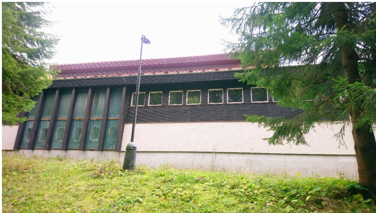
Obrázek 6 - Úpravna vody, stávající stav
