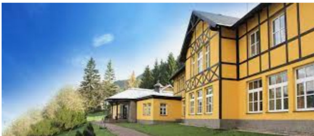
Obrázek 8 - Budova II. stupně ZŠ
