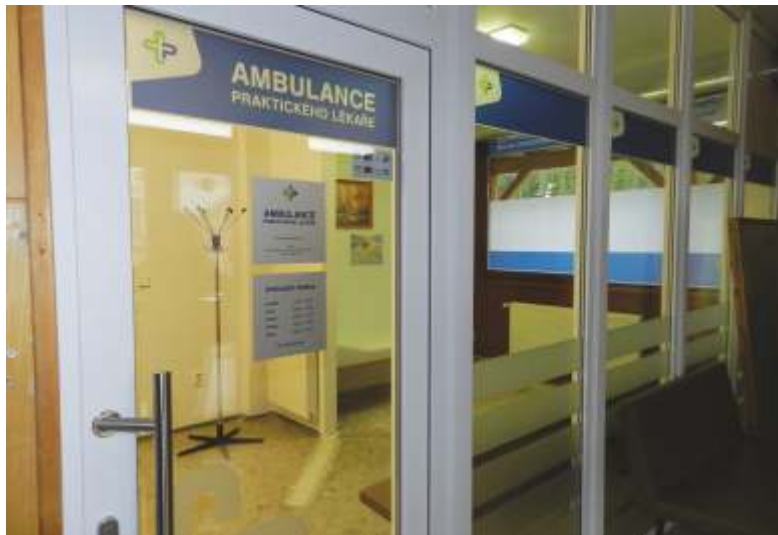
Nové vstupní dveře do rozšířené čekárny praktického lékaře v Domě služeb.
