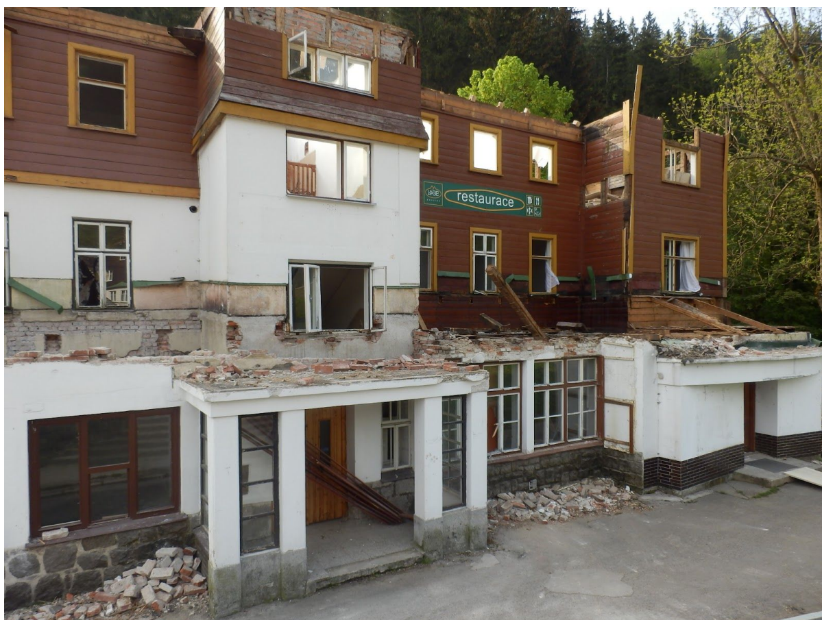
demolice Penzionu Labe
