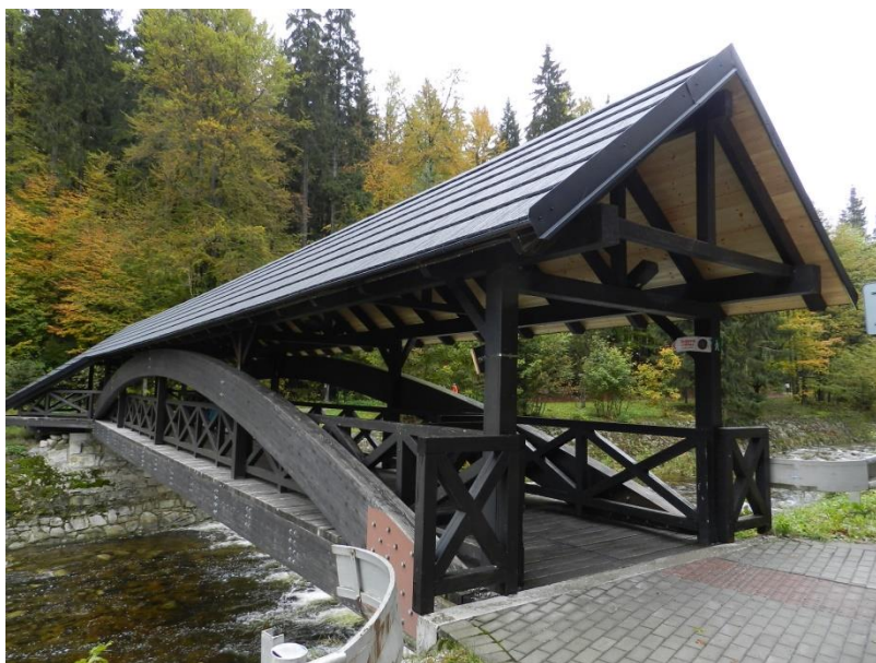
Foto: D. Palátková - oprava střechy
