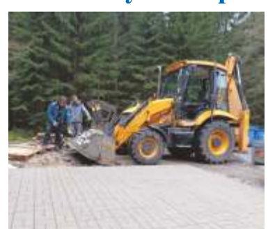
Stavba místa pro budoucí zastřešené stanoviště ve Sv. Petru pořízená v čase uzavírky vydání Šp. novin. Foto: -dp-
