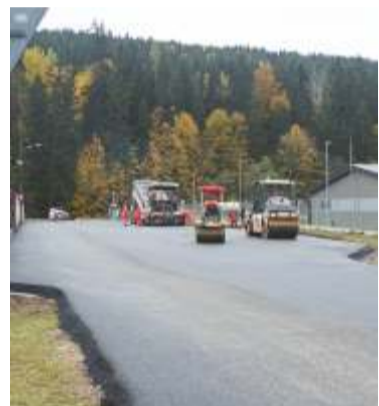
Intenzivní pracovní nasazení při přípravě nového nájezdu, který zlepšuje koordinaci dopravy na hlavní silnici a důstojného parkování pro všechny. Foto: -dp-
