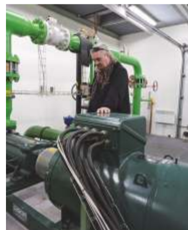
Kontrola čerpacích stanic na Medvědině.
