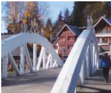
Bílý most v centru města bude opraven. Foto: -dp-
