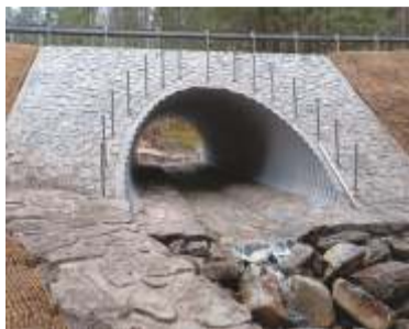
Oprava mostu dokončena.
