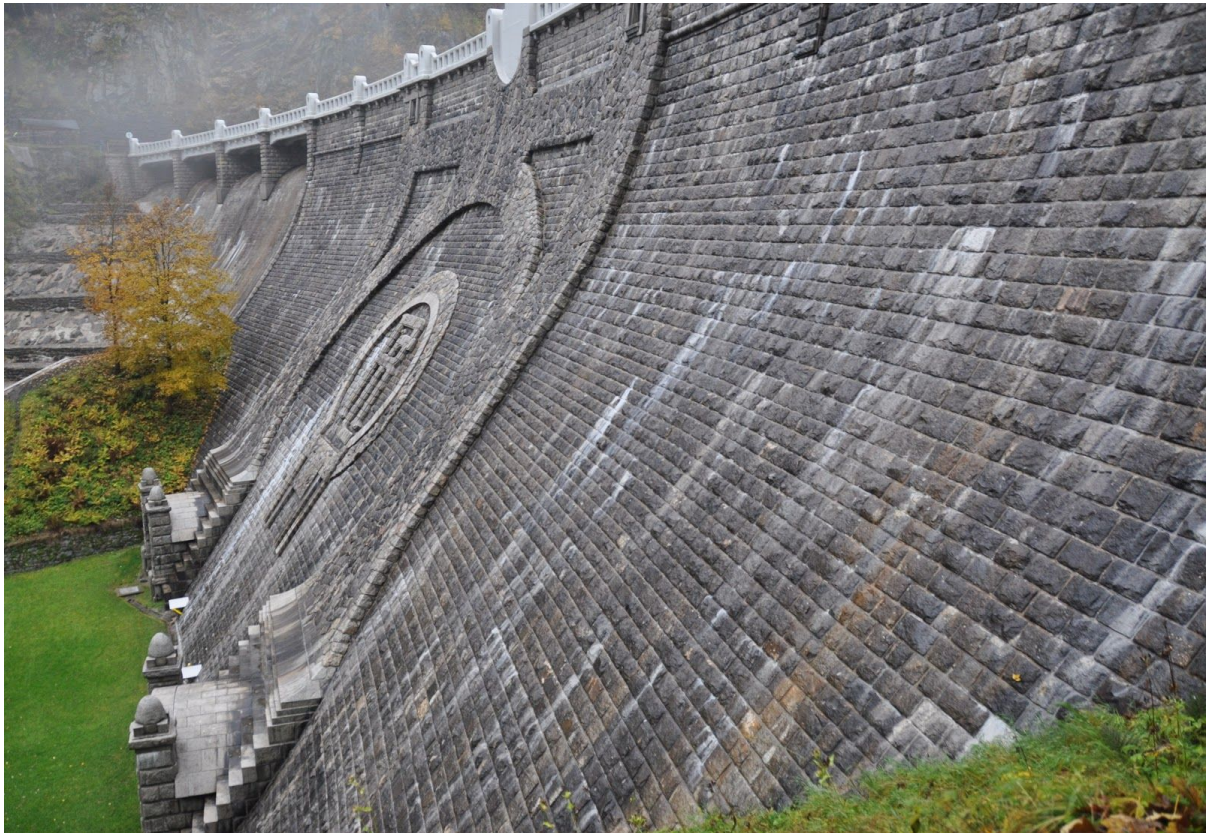
hráz vodního díla Labská
