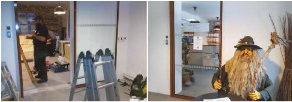
Ilustrační snímky ze stavební úpravy vstupních dveří do TIC a dokončeného díla.
