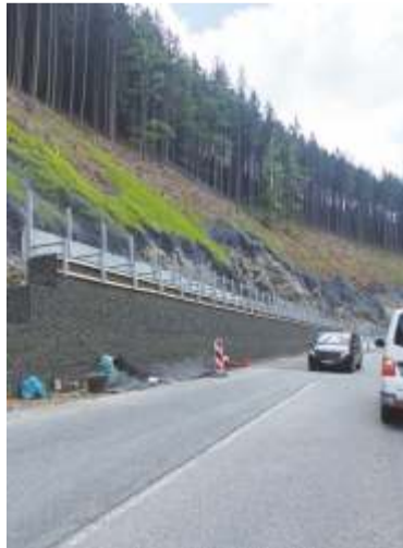
Odpadávkám skalních úlomků na silnici by měl zabránit systém ochranných ocelových sítí. Stabilizace skalních svahů probíhala nad touto jedinou přístupovou silnicí do Špindlerova Mlýna již v minulosti, například na osmikilometrovém úseku mezi Herlíkovicemi a Labskou přehradou. Foto: -dp-
