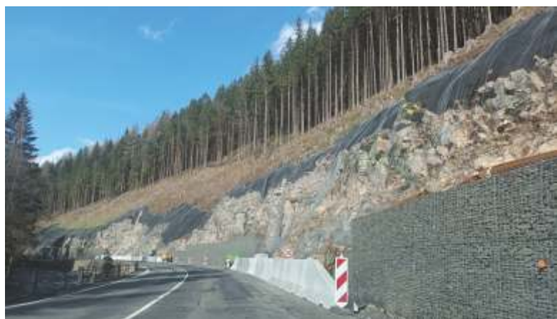
Odpadávkám skalních úlomků na silnici by měl zabránit systém ochranných ocelových sítí. Stabilizace skalních svahů probíhala nad touto jedinou přístupovou silnicí do Špindlerova Mlýna již v minulosti, například na osmikilometrovém úseku mezi Herlíkovicemi a Labskou přehradou. Foto: -dp-
