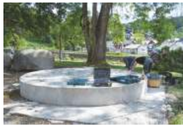
Dokončovací práce u pódia v městském parku. Foto: -dp-
